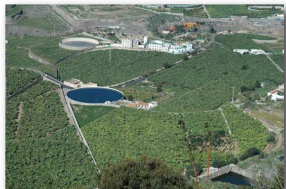
Estanques circulares de hormigón
