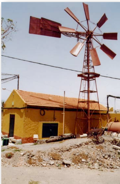
Aeromotor y Casa de Máquina de Los Calderines. Telde
