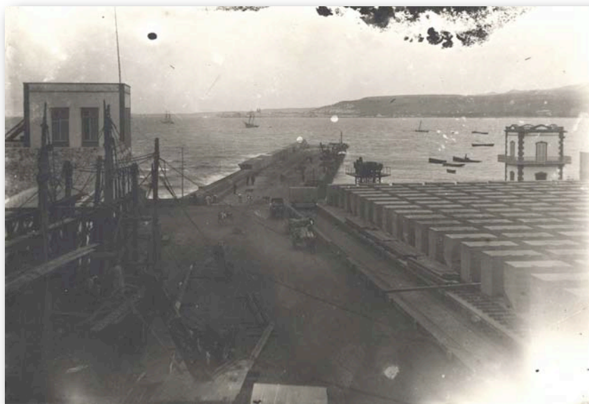
Construcción del Muelle Grande.
